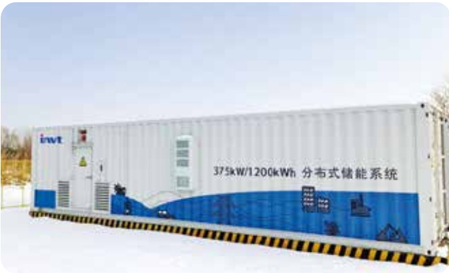
Расположение: Фошань, Китай Мощность: 375кВт/1.2МВтч Модель: BD100KTR, BD250KTR-T
