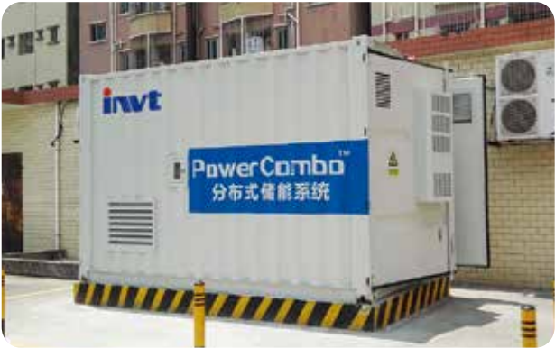
Расположение: Дунгуань, Китай Мощность: 500кВт/300кВтч Модель: BD500KTR
