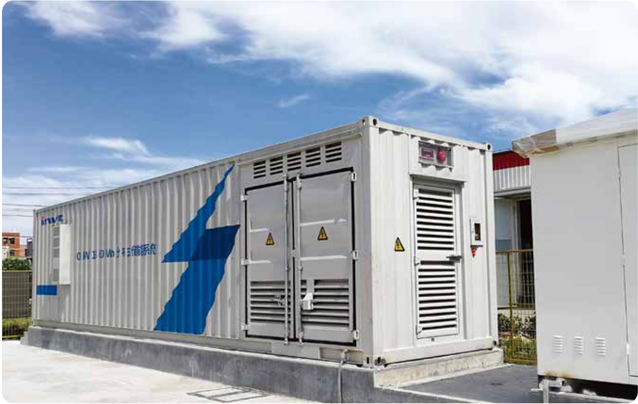
Расположение: Фошань, Китай Мощность: 375кВт/1.2МВтч Модель: BD100KTR, BD250KTR-T
